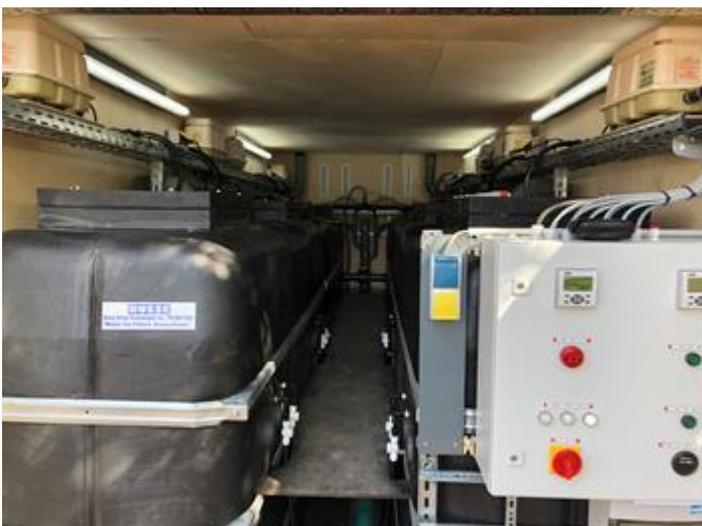
Blick ins Innere des Containers. Ein begehbare Steg zwischen den Tankreihen ermöglicht ein problemloses Arbeiten an den erhöht angebrachten Luftgebläsen und sichert den Zugang zu den im Tank eingebauten Membranmodulen.
