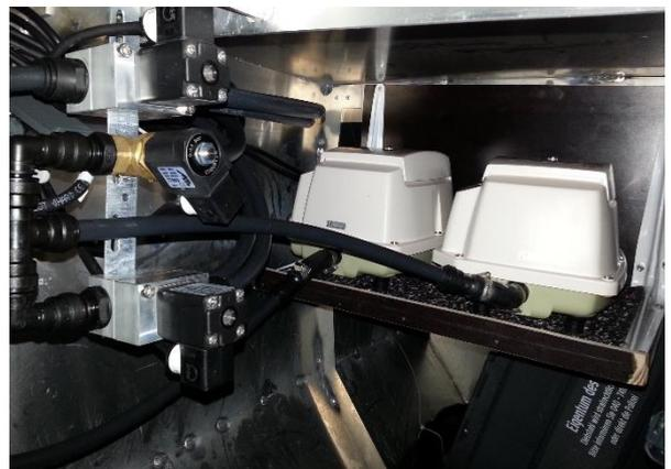
Magnetventile und Verdichter im Schallgeschützten Maschinenraum
