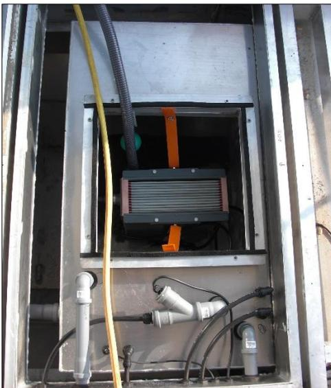
Belebungsstank mit eingebautem Membranmodul
