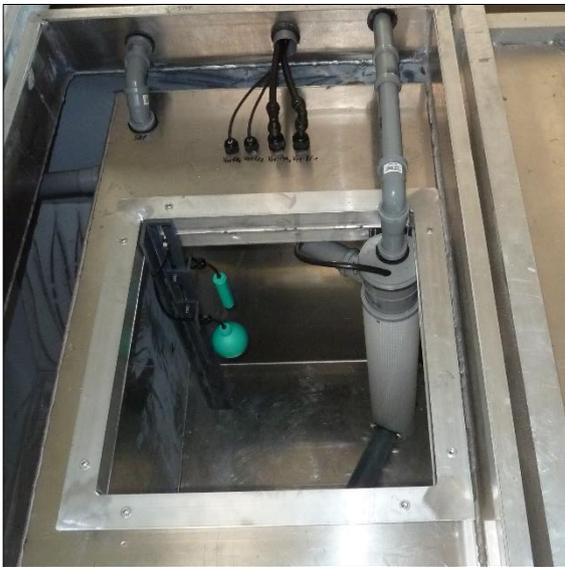
Vorklärbehälter mit belüftetem Grobstoffabscheider und Schwimmerschalter im Schwimmkörper, geöffnet...
