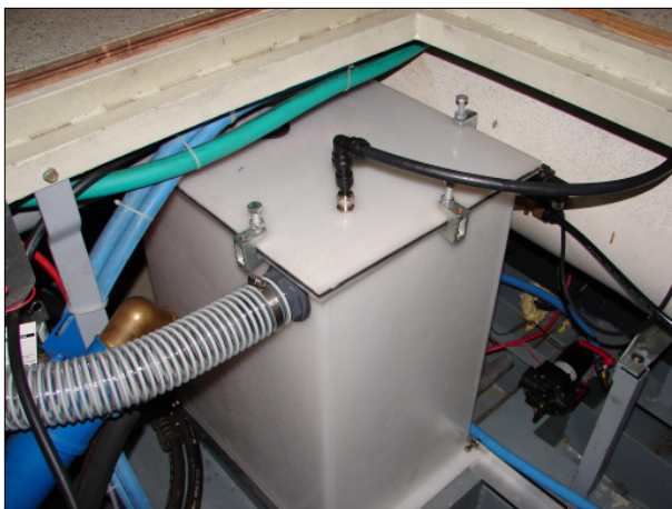
Membranbioreaktor im Maschinenraum
