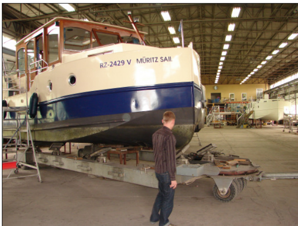
Boot in der Werft beim Einbau der Kläranlage
