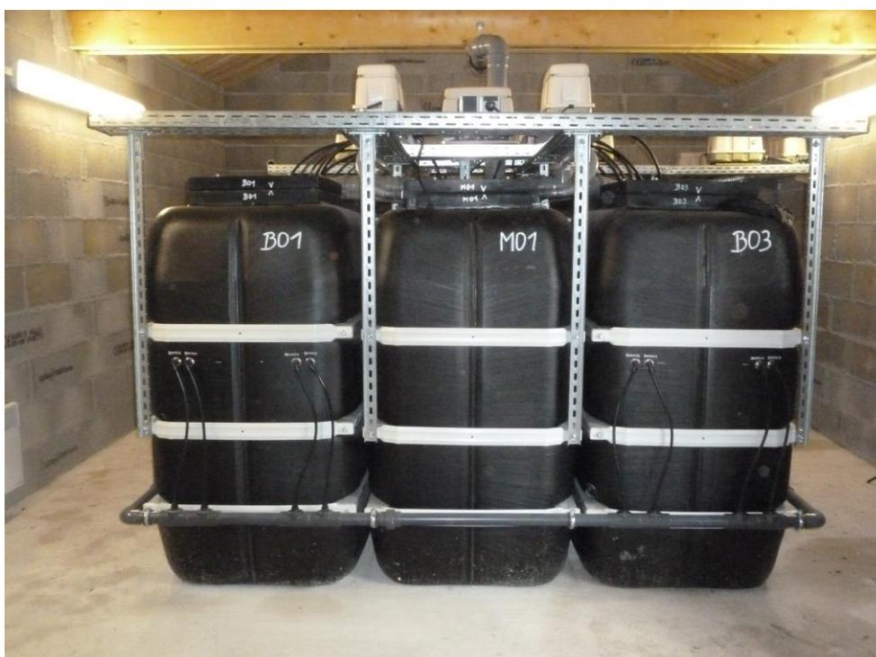
Installierte BUSSE-MF mit insgesamt 4 Tanks á 3.600 Litern.
