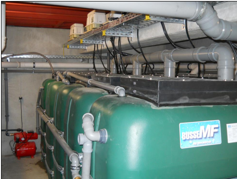
Gesamtansicht der Anlage
