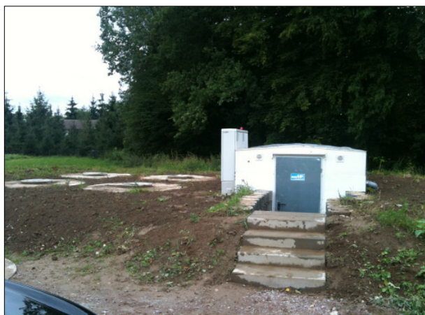
Erdmodul mit Abwassergruben am Aufstellungsort
