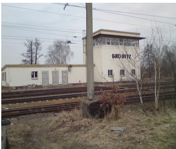
Außenansicht Stellwerk Gröditz
