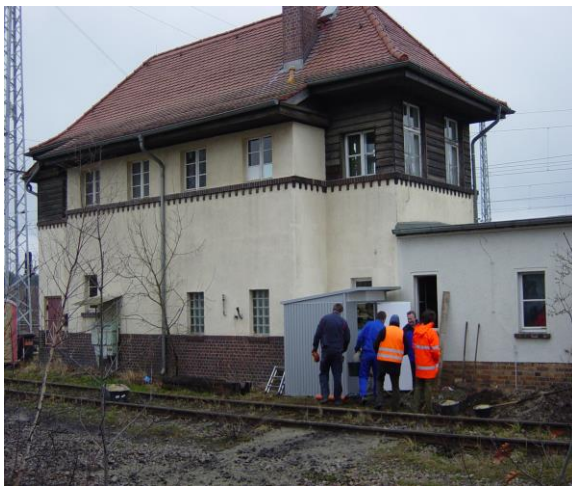
Außenansicht Stellwerk Schwarzkolim // Aufstellung der BUSSE-MF
