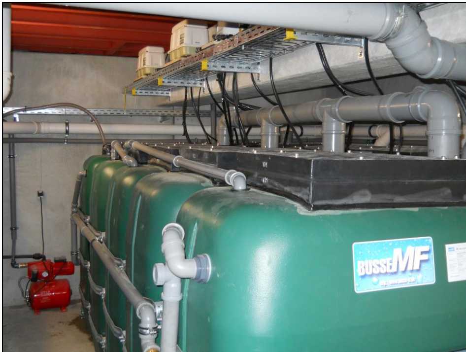
Gesamtansicht der Anlage
