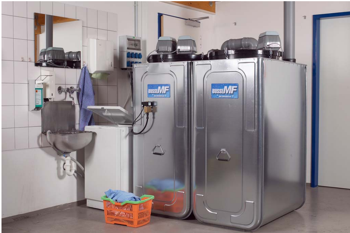
Bild 7: BusseMF für einen 4-Personen zur Aufstellung im Keller des Hauses
